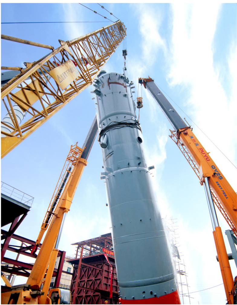
▲ 2004 年 11 月 4 日,20 工程高低变温炉吊装
