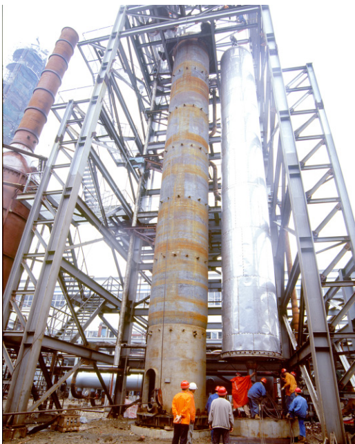
▲ 氨合成塔内件吊装
